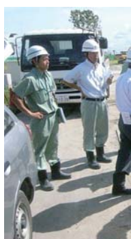
自治体の担当職員もいる公共工事現場
